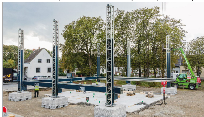
1. ábra: Építési helyszínen felállított BOD2 nyomtató (Forrás: PERI)
